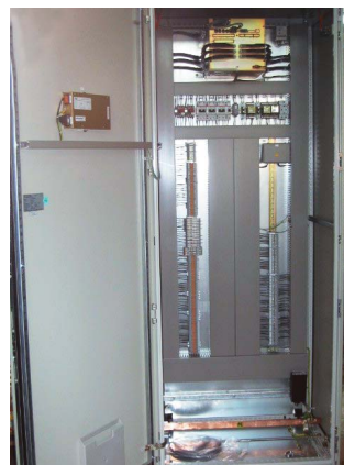
图3-3: 快速切换装置 SUE 3000 的安装
