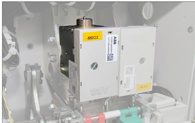
Como acontece com o relé de abertura -MBO1, permite comandar a abertura do aparelho à distância; pode ser alimentado pelo mesmo circuito do relé de abertura principal -MBO1 ou por um circuito completamente separado do relé -MBO1.
