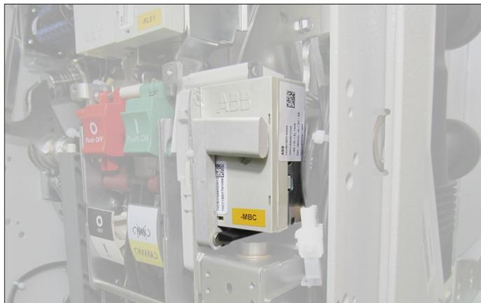
Permite o comando de fechamento à distância do aparelho. Este relé é adequado tanto para serviço instantâneo, como para serviço permanente; não é previsto que um contato auxiliar corte a alimentação dele uma vez fechado o disjuntor. O relé alimentado permanentemente exerce a função de antifechamento elétrico (antibombeamento) com ambos os comandos elétricos de abertura e de fechamento mantidos. Para garantir o fechamento, a duração mínima do impulso de corrente deve ser de 100 ms.
