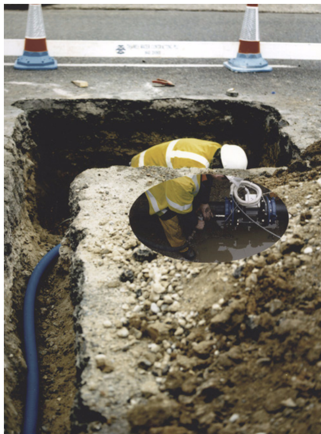
Installation enterrée d'AquaMaster
