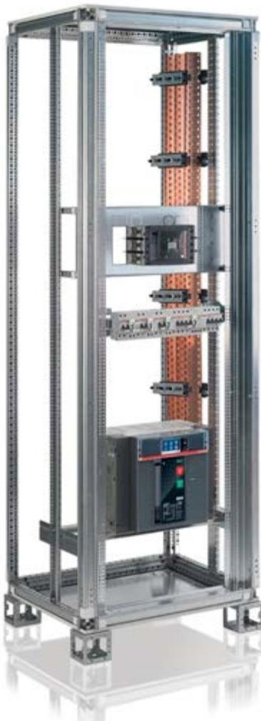
Les traverses qui se fixent à la structure sont à usage universel pour les supports de barres linéaires et en escaliers.
