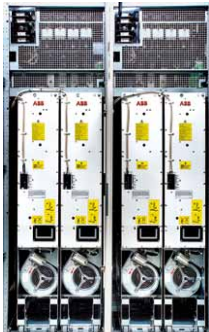
SAMI STAR -vaihtosuuntaajayksiköt (yllä) ennen jälkiasennusta ja uudet ABB:n teollisuustaajuusmuuttajat, jotka on asennettu SAMI STAR -kaappeihin (alla).
