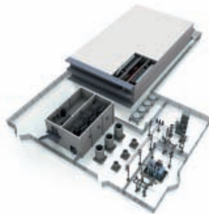
9 SVC Light® avec stockage d'énergie
