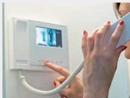
Per la realizzazione di Cascina Merlata sono stati impiegati posti interni con monitor a colori da 4.3" e posti esterni con display e tastiera numerica.
