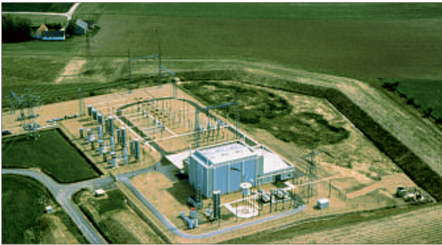
Station de conversion de la liaison CCHT par câble de la Baltique
