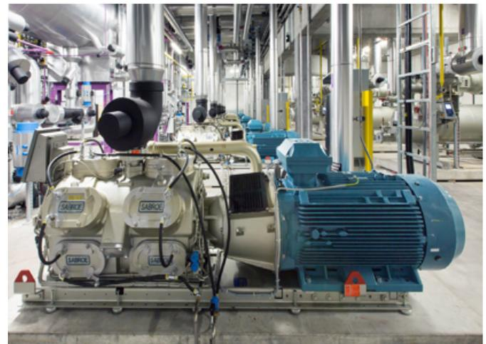
Drehzahl/Frequenz des ersten Verdichters so an, dass die Systemleistung den Prozessanforderungen entspricht. Wenn der Bedarf weiter ansteigt, fügt die PFC-Logik weitere Hilfskompressoren hinzu.
