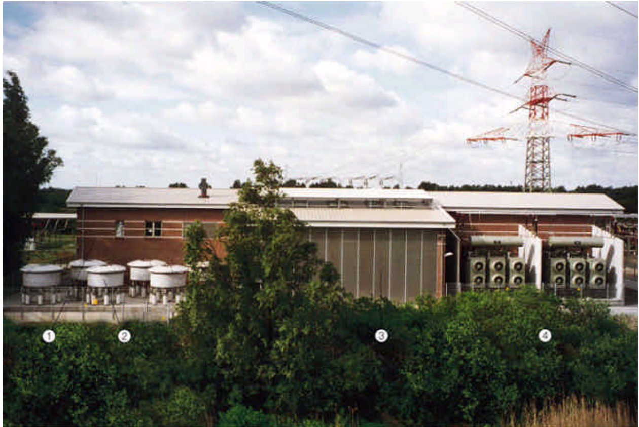
100-MW frequency static link of Stadtwerke Bremen
