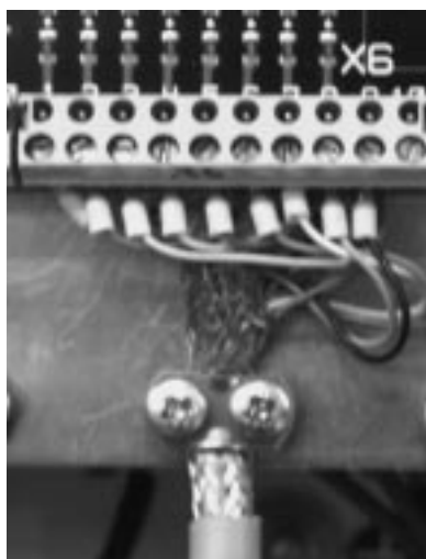
Figura 5.2 - 4 Conexão da blindagem do cabo à superfície metálica, com o auxílio de uma abraçadeira metálica.
