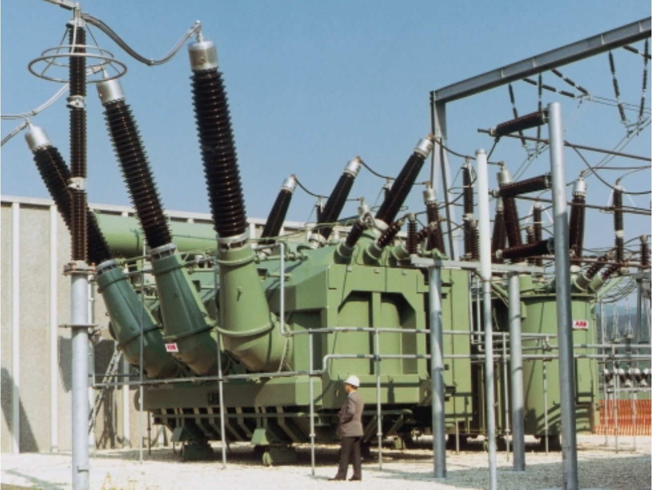
Montage économique pour le réglage longitudinal et transversal séparé de groupes de transformateurs de 400 MVA pour 400/370 ± 17 × 2,06/49 kV
